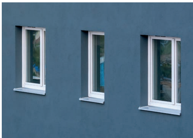
Elewacja z prawidłowo zabezpieczonym talerzem łącznika mechanicznego.
